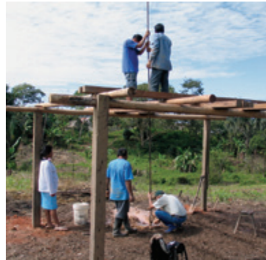
Manfred Kämpf von Indicamino (auf dem Bild unten Mitte) beginnt zusammen mit Einheimischen mit der Grundwasser-Bohrung. Das Bohrgerät wird mit Menschenkraft betrieben.
