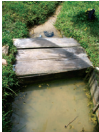
Einzigste Wasserstelle bis 2007 vor dem Bau eines Grundwasser-Brunnens.
